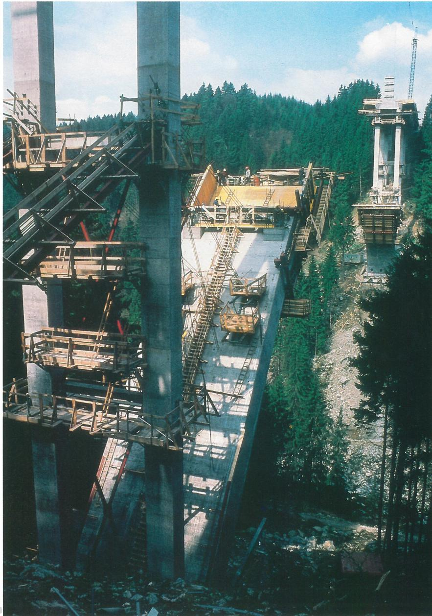
Bogenfreivorbau mit Hilfsabspannungen nach dem von MAYREDER patentierten System
