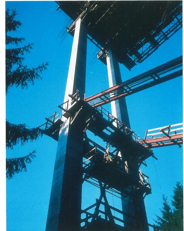
Abgestützte und ausgesteifte Kämpferstütze mit 52 m Höhe
