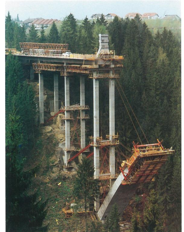
Das Kämpferstützenpaar ist 52 m hoch, dient zur Ab- und Umleitung der Bogenabspannungen
